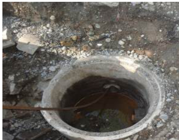
Als erstes wird ein 22 mm Stahlseil durch das Altrohr geschoben.
